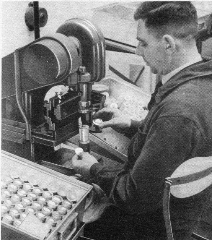
4. Der sternartige Kern mit feinem angenieteten Bakelitdeckel wird nun in das Aluminiumgehäuse eingefalzt und damit unverrückbar mit ihm verbunden.
